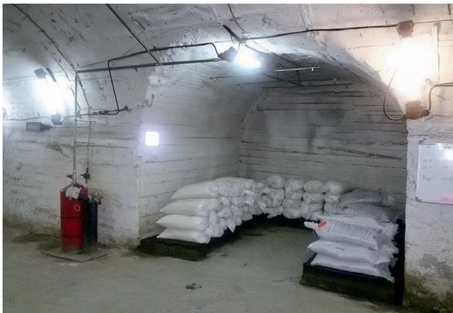
Подземный расходный склад ВМ и пункт изготовления ВВ оборудованные автоматическими (автономными) установками пожаротушения
